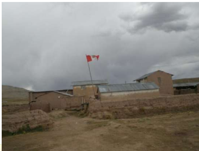
Foto Nº 24 Infraestructura de las viviendas
